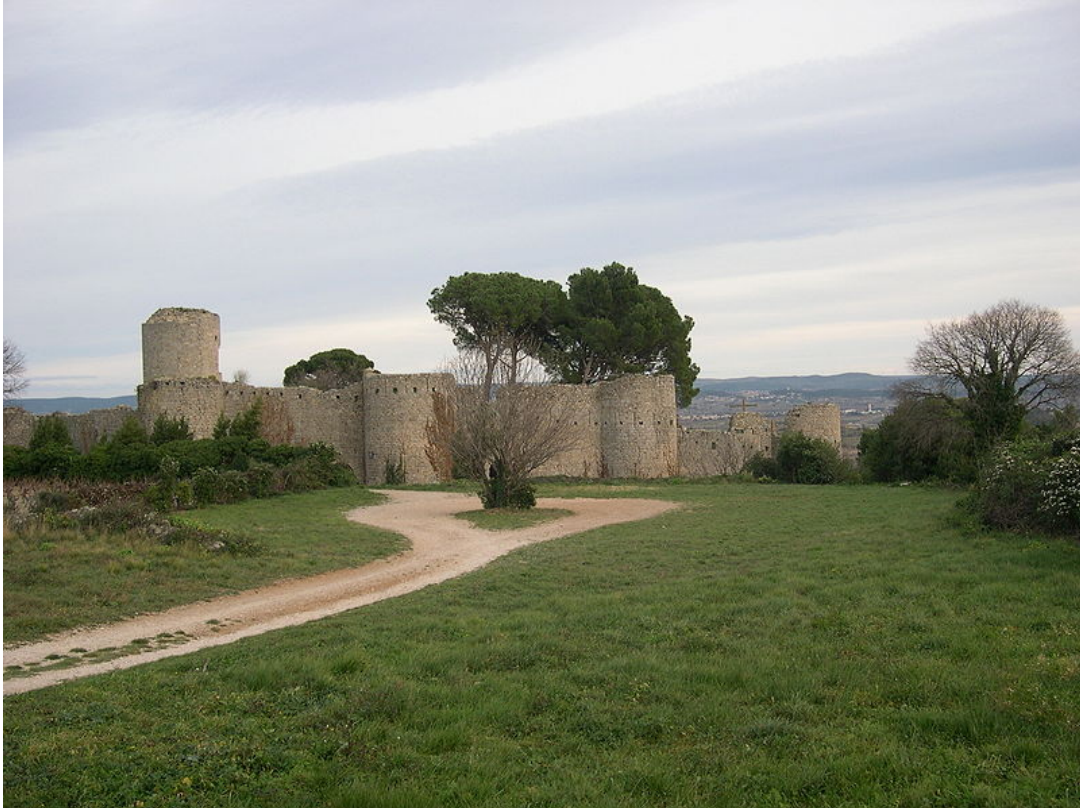
Le château fort de Clermont-l'Hérault (34) vu du côté ouest
